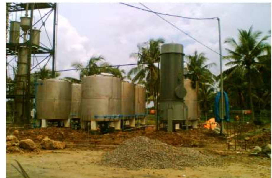
PROYEK : PABRIK BIOETHANOL - REMBANG
